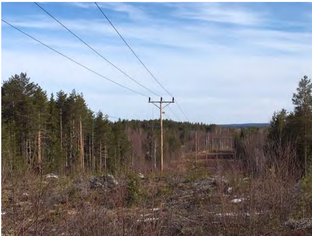
Figur 4: Utformning 4088 ByTill(1) Lindhaga-Töre, tre faslinor upphängda i enkelstolpar av trä.
