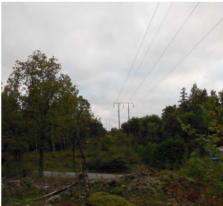
Figur 13. Befintlig 70 kV ledning på Helgö. Den planerade ledningen kommer uppföras på östra sidan om den befintliga ledningen som därefter rivs. Fotot är taget mot söder.
