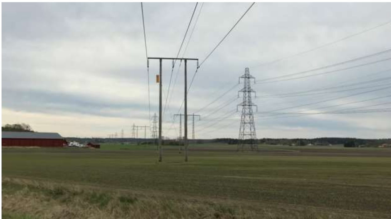
Figur 21. Jordbrukslandskap kring Slåsta där befintlig ledning och den planerade ledningen ansluter till Svenska kraftnäts ledningar i en gemensam ledningsgata mot Måby. Vy mot söder.
