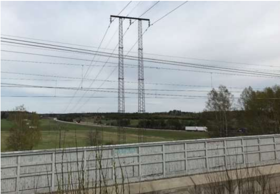
Figur 13. Befintlig gitterstolpe vid passage av Arlandabanan vid Åslunda. Till höger syns E4an.
