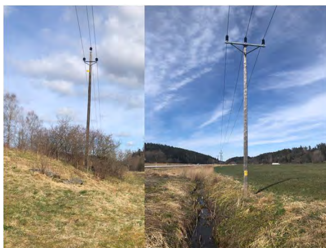
Figur 6. Befintlig ledning TL3 längs sträckan Museröd-Vräländ. Exempel på enkelstolpar i trä.
