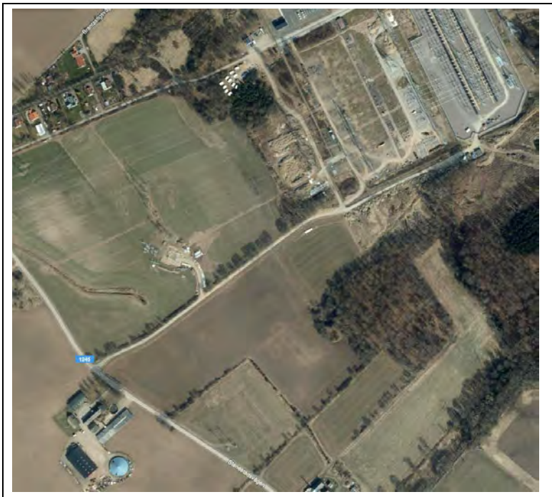
Figur 3. Stubbe under byggnad. ST0002 på ledningen FL7 S5-6.
