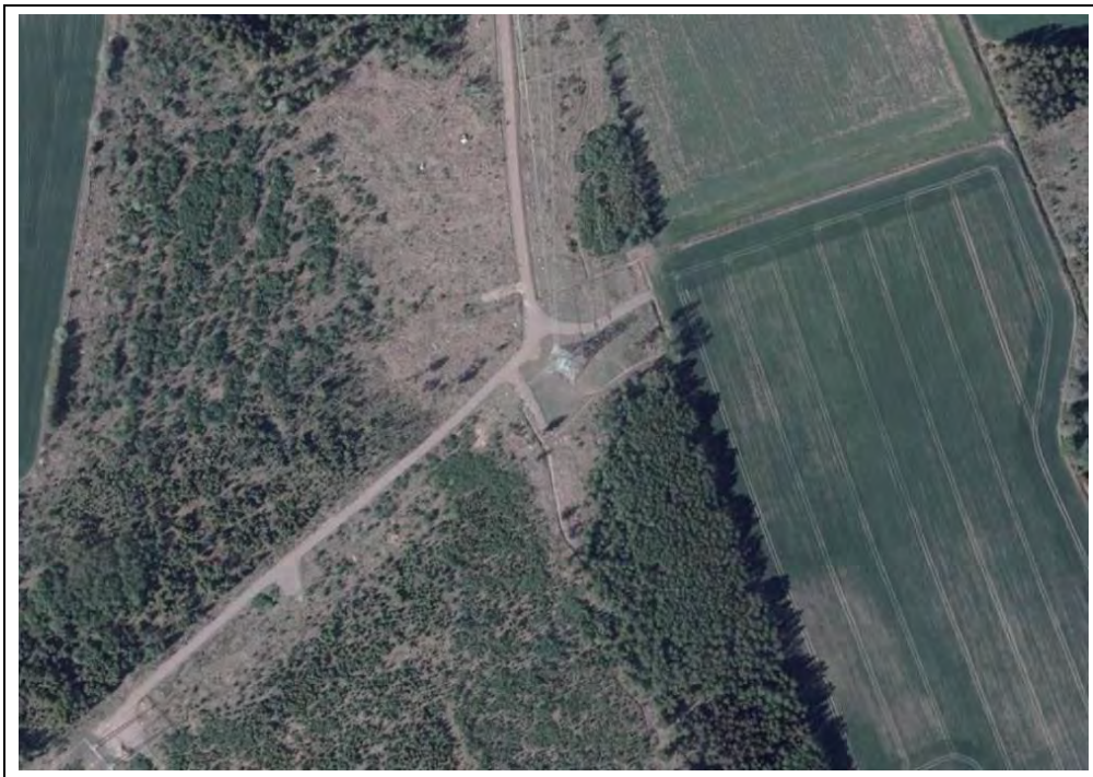
Figur 10. FL31 S3-4 med vinkelstolpe ST0258.
