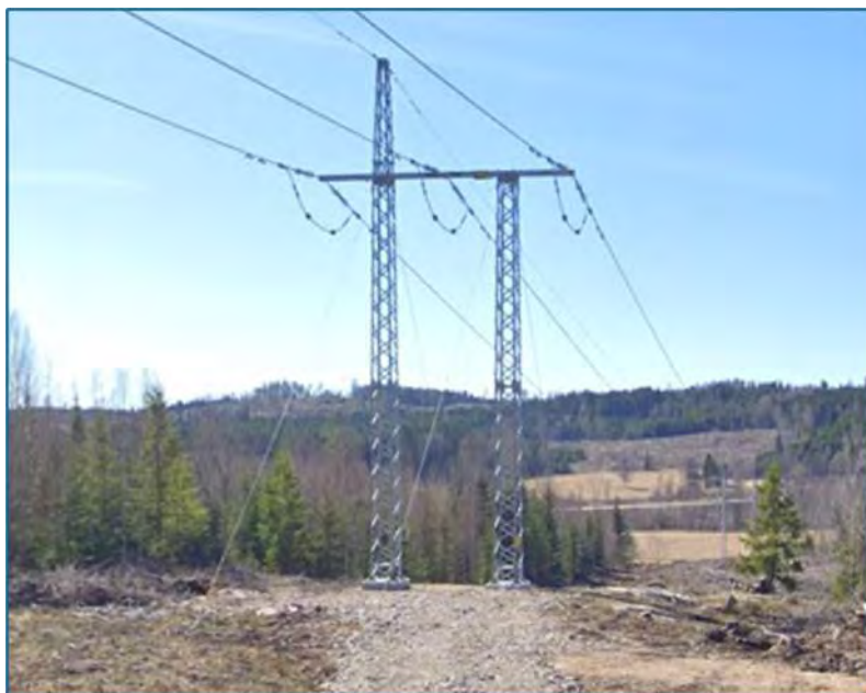
Figur 1 Portalstolpe i stål med en topplina
