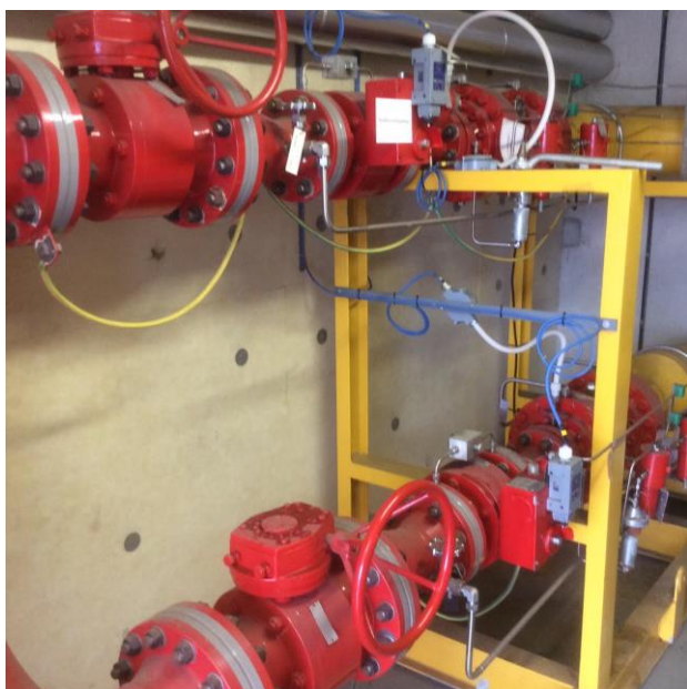
Bild 1:2: RS Orienten, reducerlinjer Tormene, axialregulatorer med monitor
