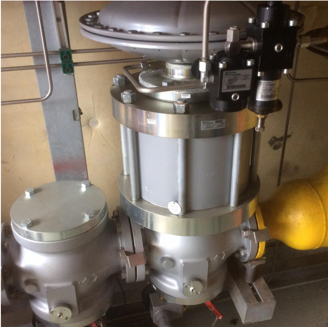
Bild 2.3: Ny reducerenhet 16 – 4 bar. Regulator och snabbstängningsfunktion SSV, Fiorentini.
