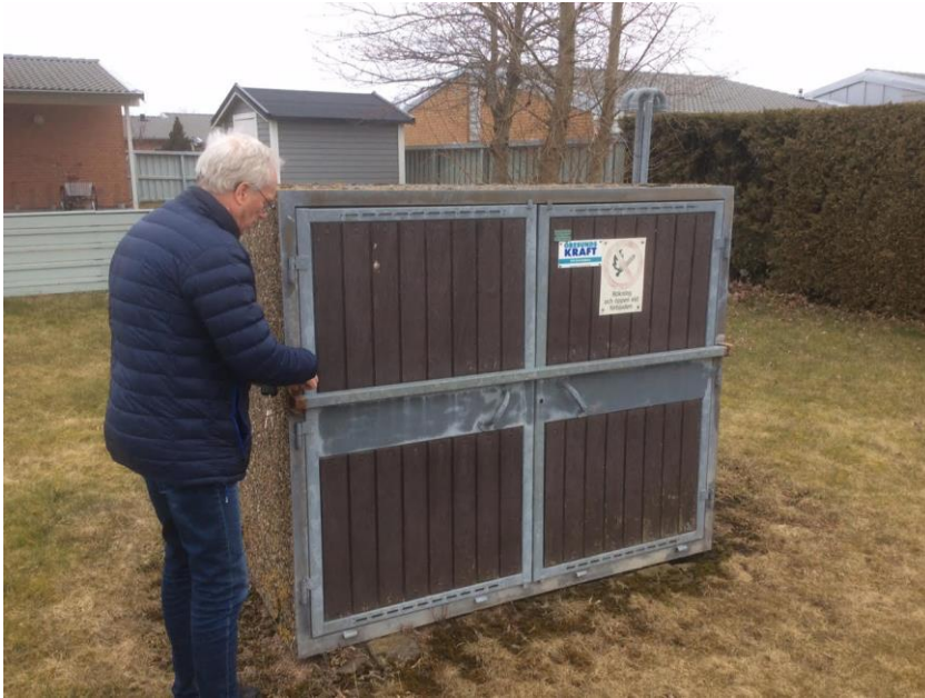
Bild 4.1: RS Rydebäck. Reglerstationen reducerar gstrycket från 4 till 0,1 bar.
