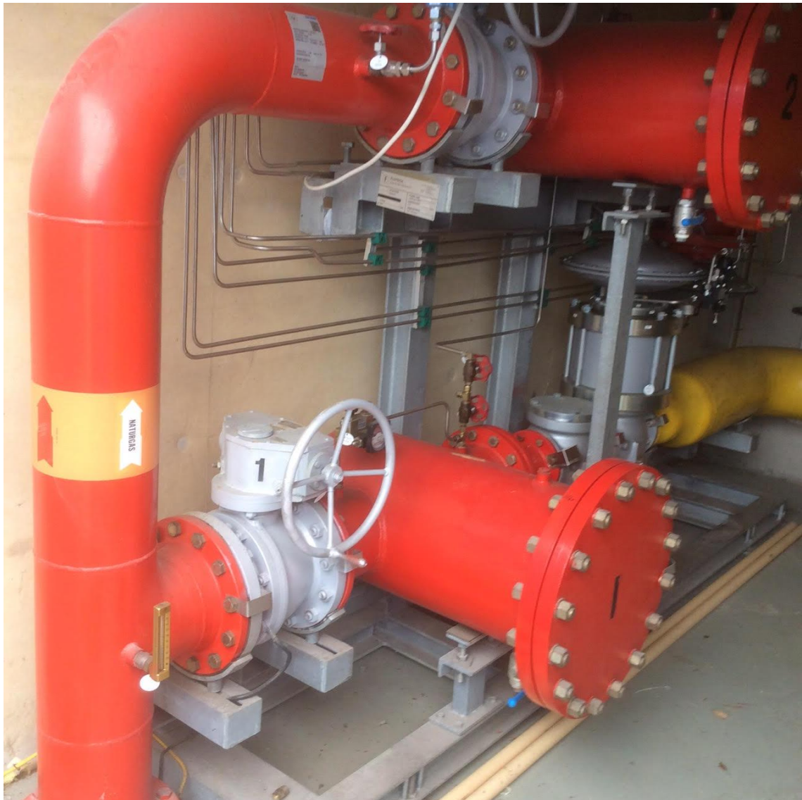
Bild 2.4: Dubbla ingående linjer, avstängningsventiler och filter.
