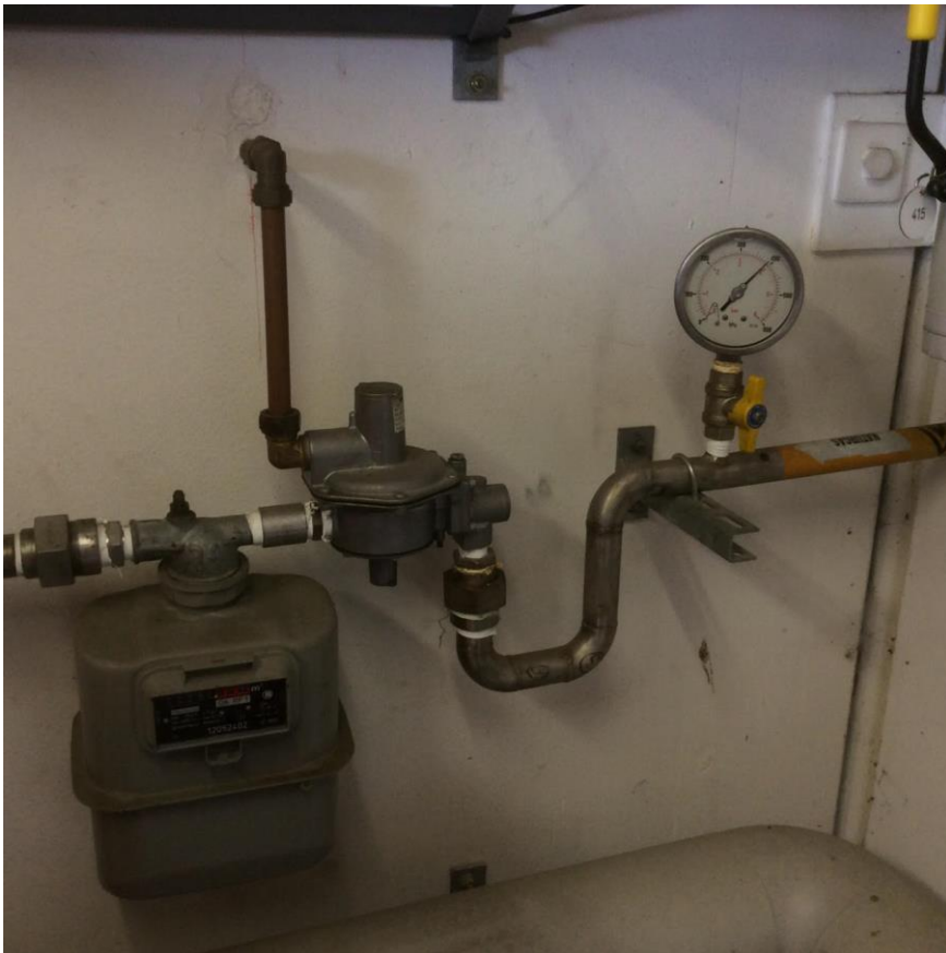
Bild 1.3: Panngasregulator o mätare
