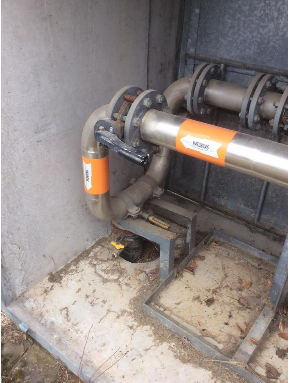
Bild 4.3: Utgående linjer, en linje förberedd för mätare. Övergång mot markledning med tejpade rör.
