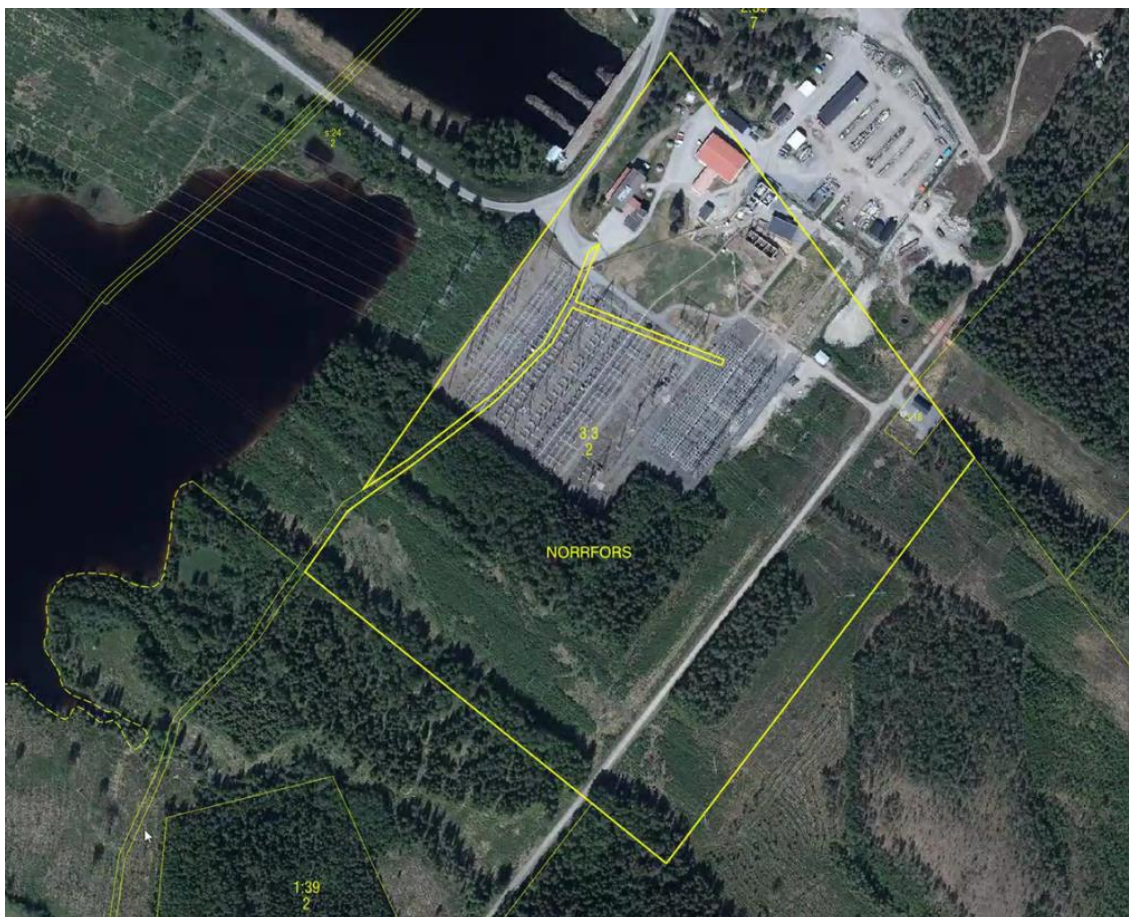
Figur 3. Ställverket som det ser ut idag. Ställverket är på Vattenfall Vattenkrafts fastighet.
