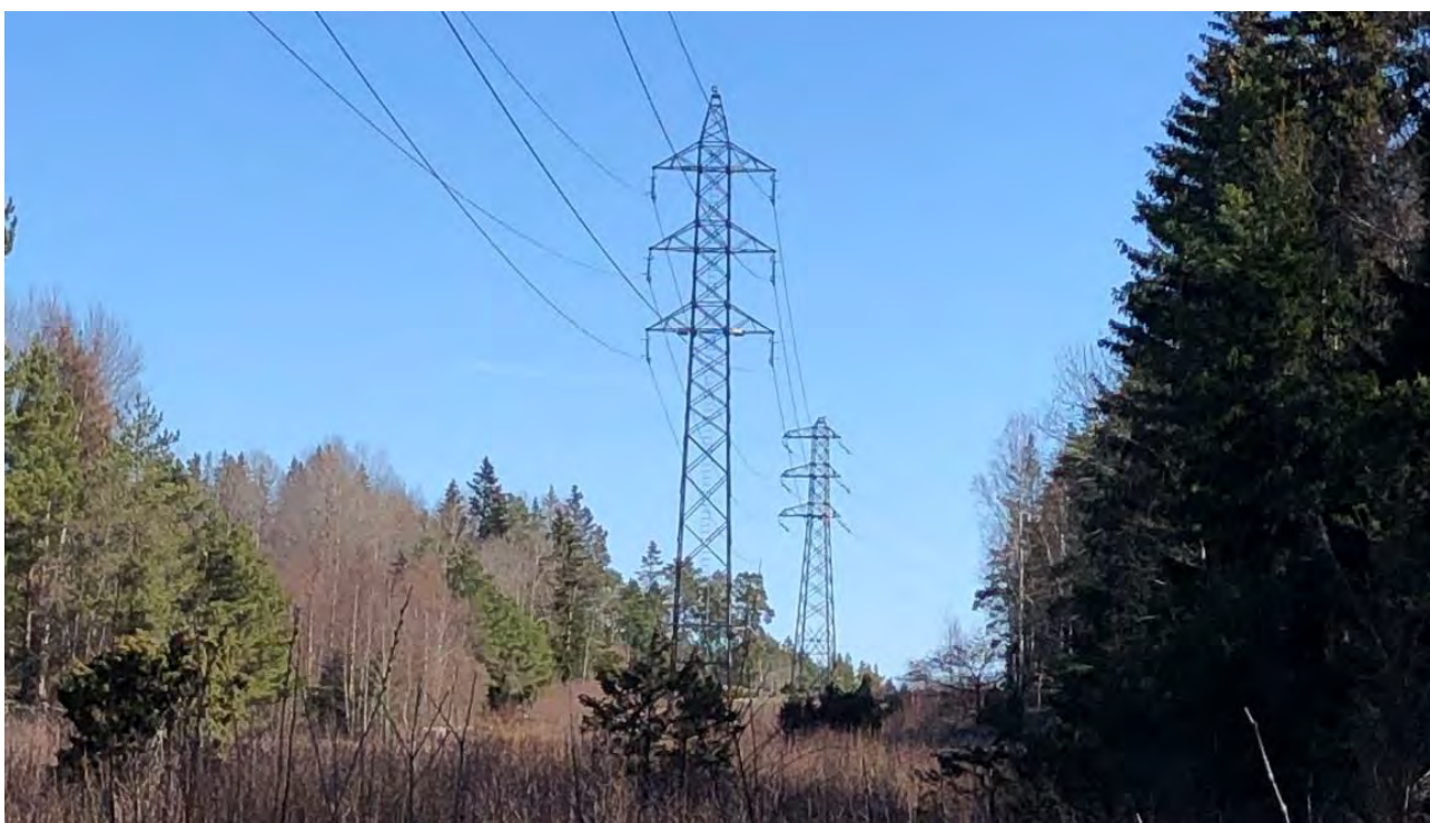
Figur 4. Foto på typ av stolpar mellan station Överby och stolpe 9 (Foto: Sweco).
