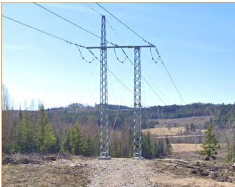
Figur 15. Portalstolpe i stål med en topplina
