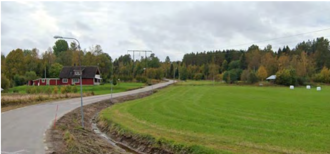
Figur 22. Foto som visar befintlig ledning vid Kungsgården och närliggande hus (B10).
