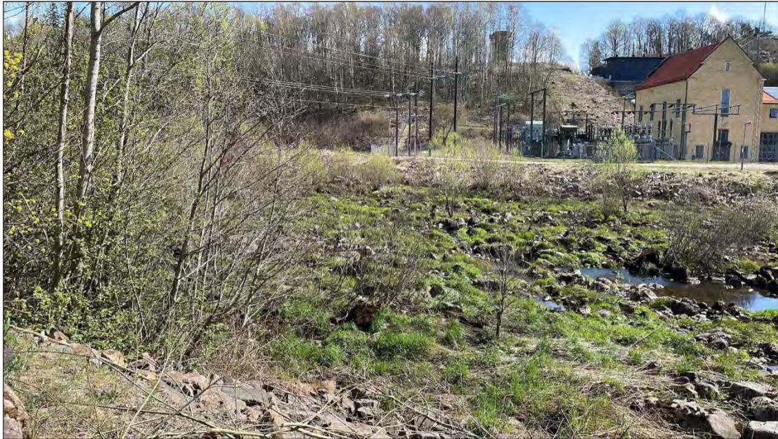
Figur 6. Närmst i bild syns torrfåran till Ätraforsdammen. I bakgrunden syns befintlig station och närliggande vattenkraftverk. Ungefärlig plats för ledningsalternativ 2.
