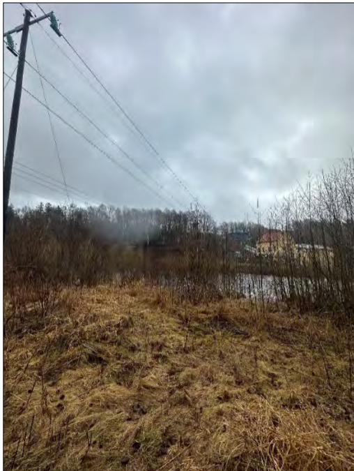
Figur 1. Befintliga ledningar sett från norra sidan vattendraget. I bakgrunden syns befintlig station och närliggande vattenkraftverk. Ungefärlig plats för ledningsalternativ 1.
