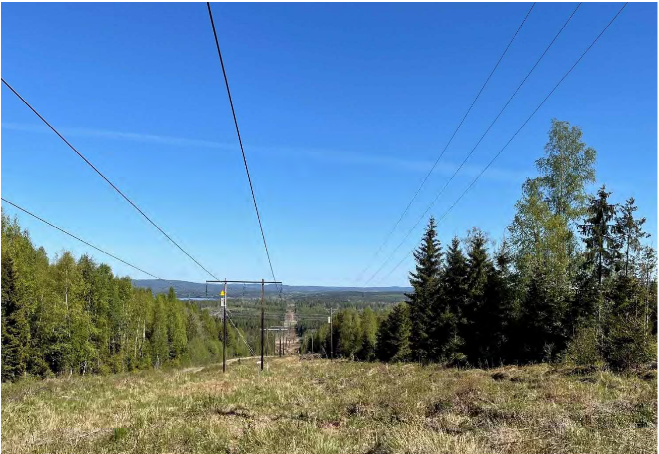
Figur 15. Befintlig ledning i östvästlig riktning som ny ledning kommer att följa intill.
