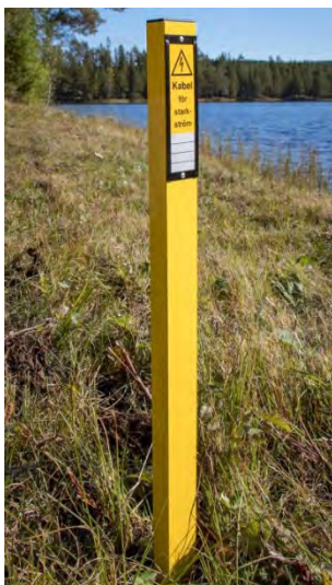
Figur 6. Exempel på käpp som markerar en starkströmskabel.
