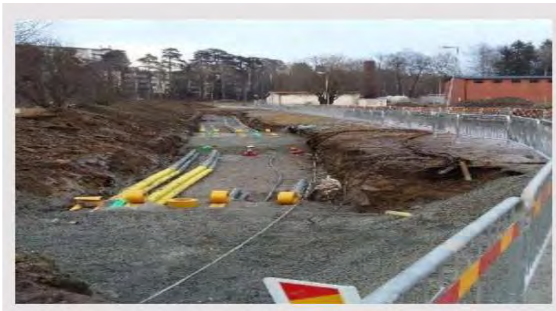
Figur 2. Fotot ovan visar arbetsområdet vid förläggning av fyra kabelförband. En markkabel kräver en trädfri skogsgata på 10-20 meter vid förläggning.
