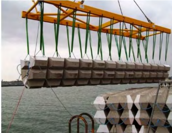
Figur 12. (T.v.) En typisk betongmadrass. (T.h.) en typisk stensäck.
