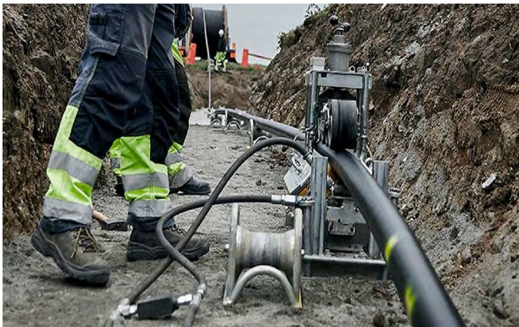
Figur 24. Exempel på kabelförläggning, kabeltrumma i bakgrunden
