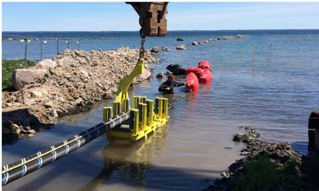
Figur 17. Nedläggning av kabel i ett öppet schakt.
