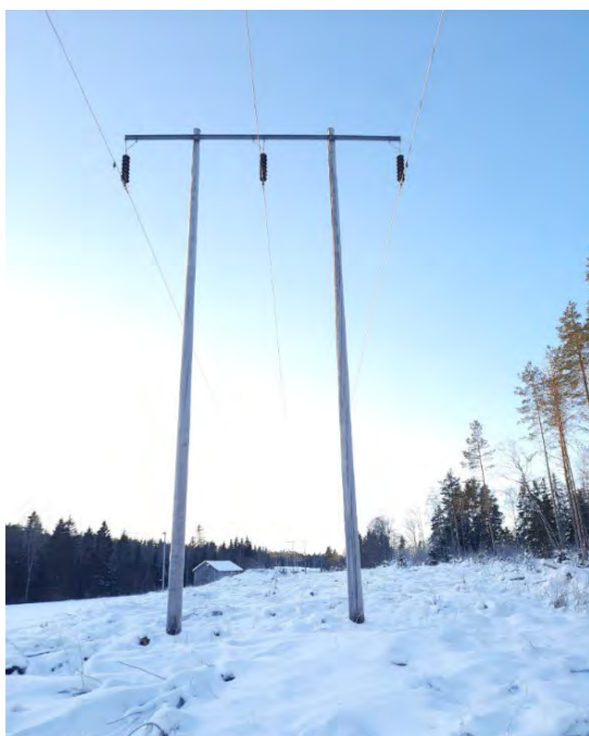
Figur 3. Träportalstolpe med horisontella faslinor tillhörande 145 kV ledning TL1. Fasavstånd cirka 4 meter.
