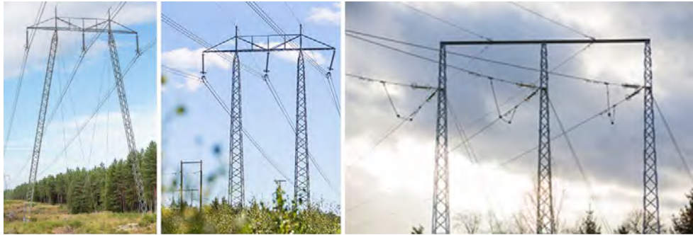
Figur 8 Exempel på portalstolpar, till vänster A-stolpe i mitten B-stolpe och till höger vinkelstolpe.
