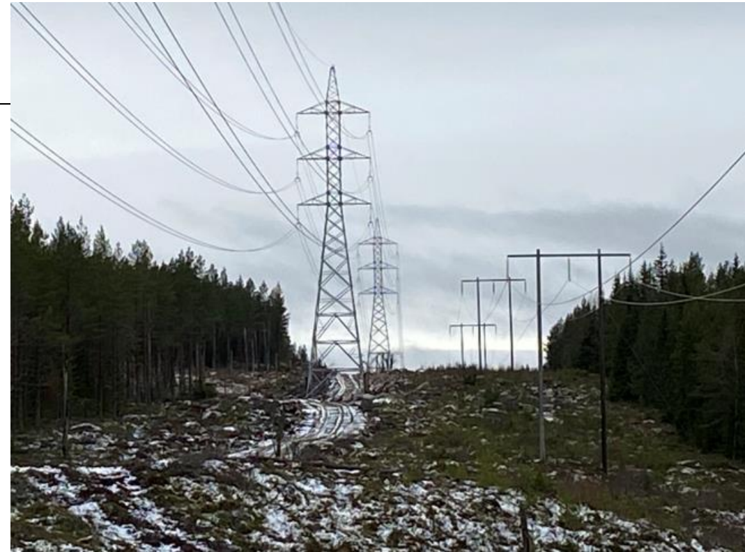
En dubbel 145 kV ledning med två linor per fas (duplex)
