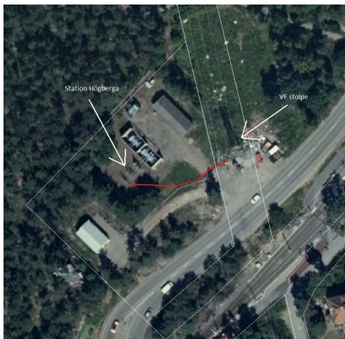
Figur 3. Station Högberga, markkabelförbandets läge i mark framgår av den röda linjen. I bilden kan även skuggan av Vattenfall Eldistributions stolpe och faslinor skönjas.
