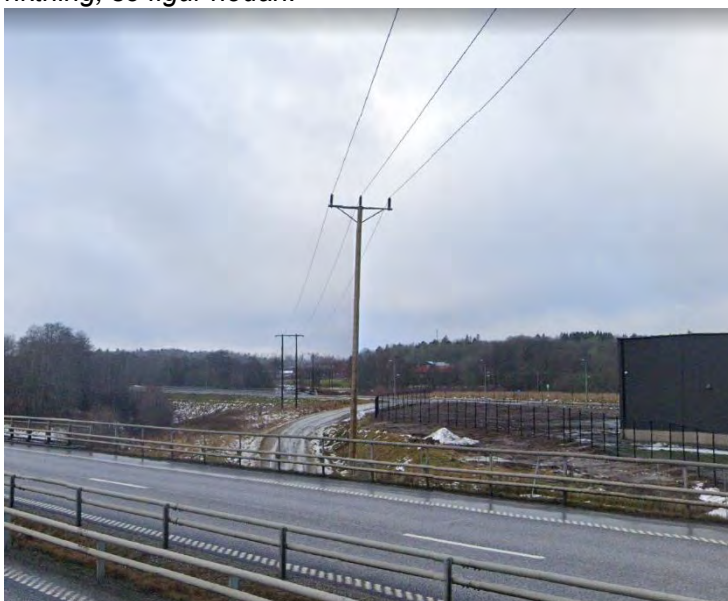
Figur 2. Befintlig ledning där den passerar E20 (källa: Google maps, 2022)
