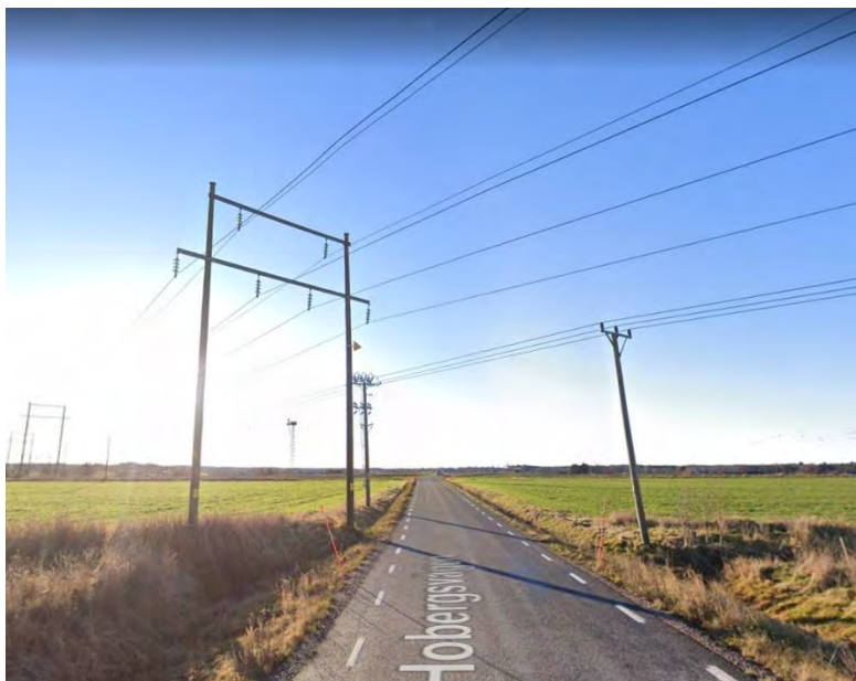
Figur 4. Befintlig ledning i sambyggd konstruktion, parallellt med en annan mindre ledning (källa: Google maps, 2022)
