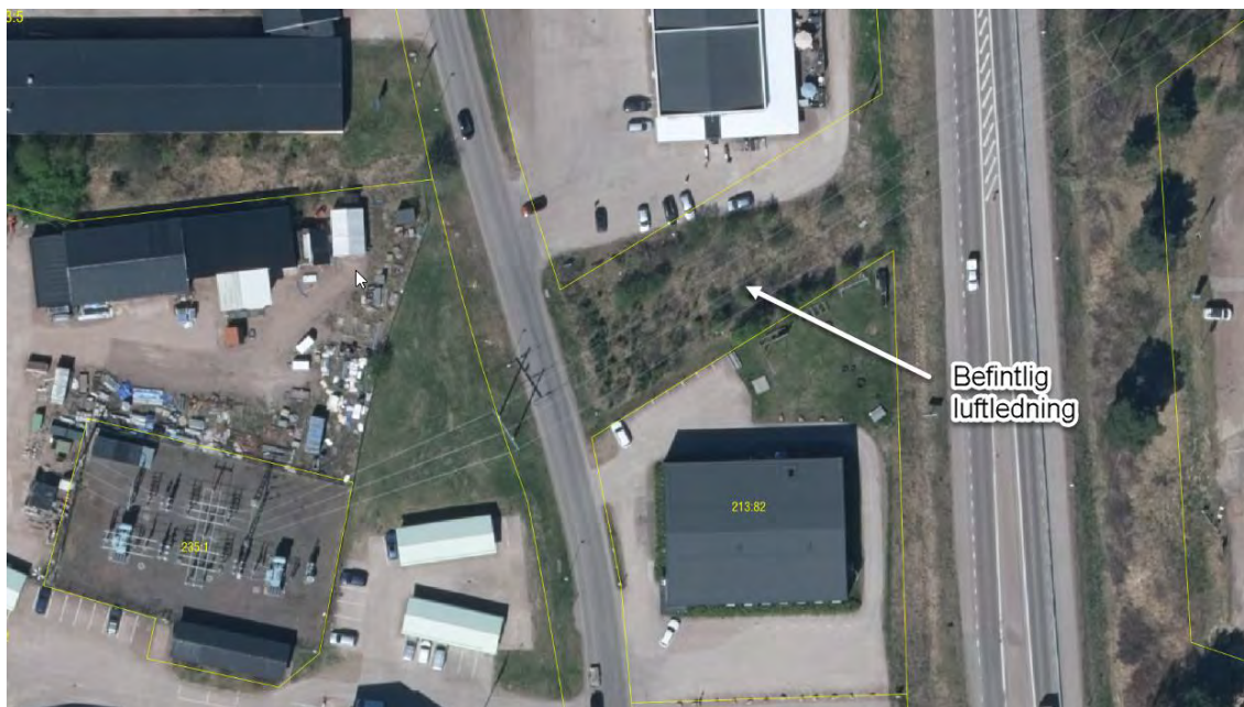
Figur 8. Bilden visar den trånga passage som är mellan befintliga byggnader intill station Öna. Bilden är kopierad från lantmäteriets digitala kartverktyg "Min karta".
