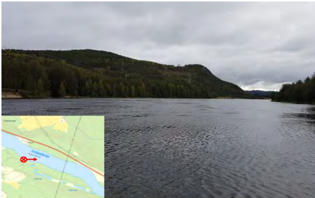
Figur 4.1: Befintlig 400 kV ledning vid korsning av Indalsälven (2018-09-18).
