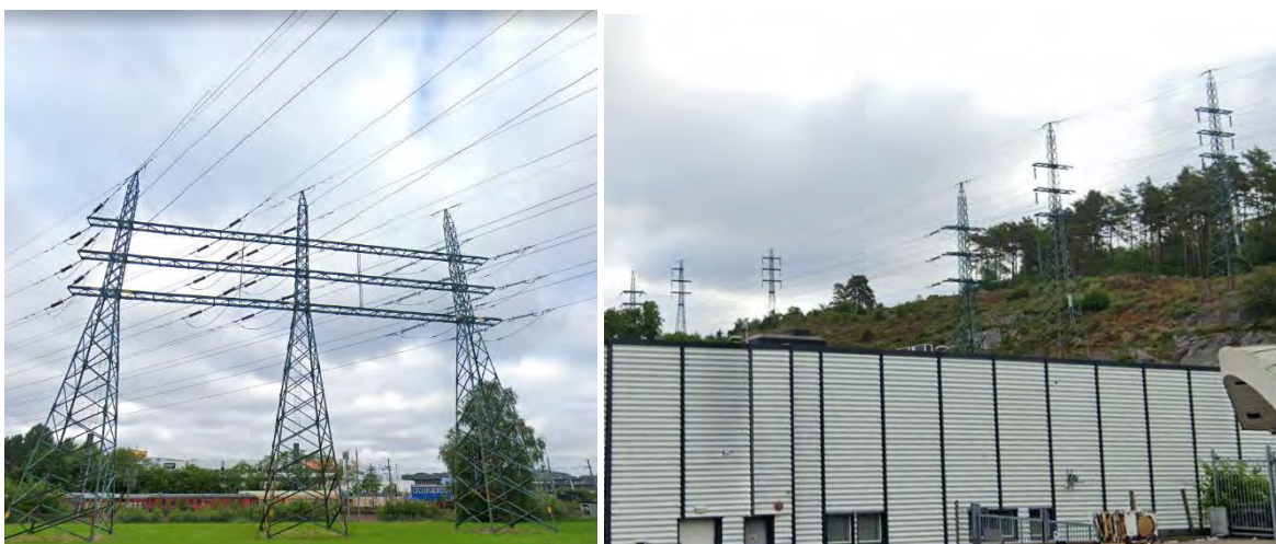
Figur 1. Till vänster: Befintliga luftledningarna som passerar Gamlestadvägen. Till höger: Del av befintliga luftledningarna vid Alelyckans industriområde.
