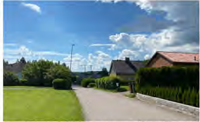
Figur 2.3. Befintlig ledning på sträckan genom Älvbro/Bengtsbo där ledningen passerar nära bostadsbebyggelse. Mitt i bild syns en ledningsstolpe och till höger skymtas ledningens faslinor bakom hustaken.
