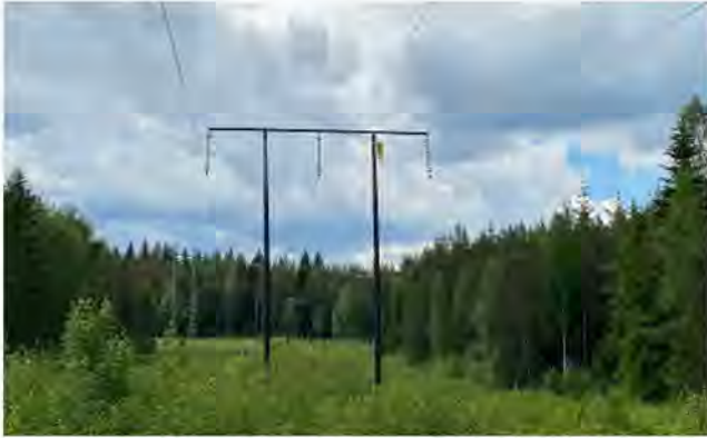
Figur 2.2. Ledningen på sträckan mellan Bjurfors och Avesta byggdes på 1980-talet med portalstolpar av trä.
