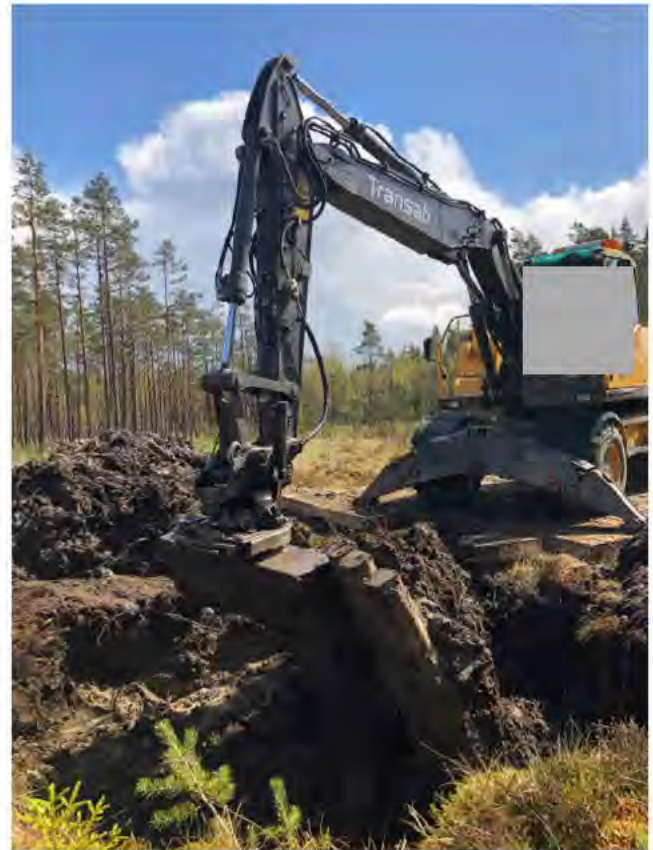
Figur 2.19. Stolpfundament grävs fram och lyfts ur schaktgropen.
