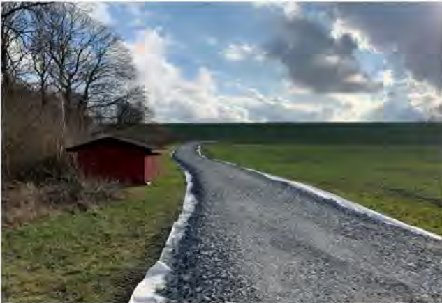
Figur 2.13. Exempel på byggväg inför ny kraftledning.
