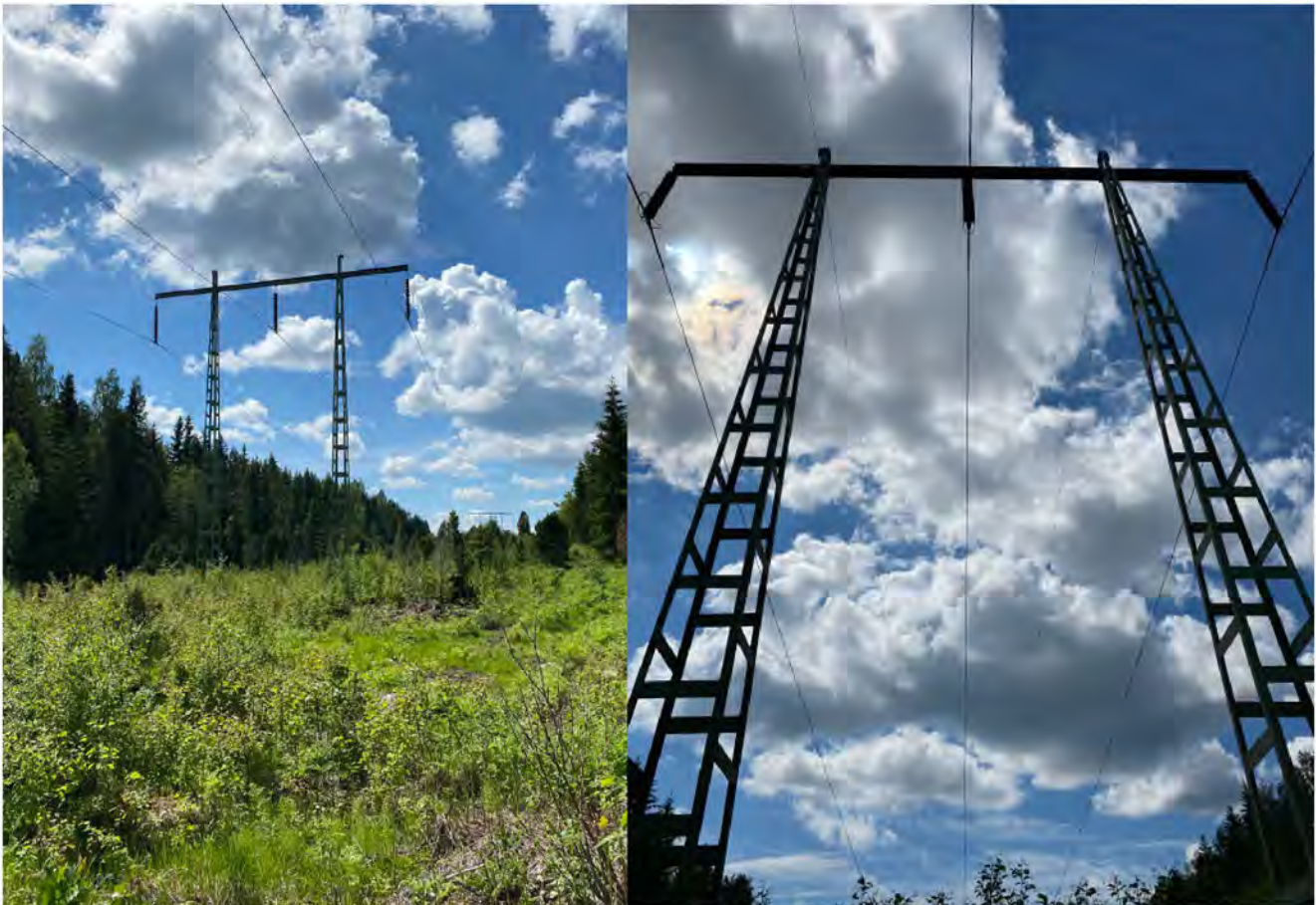
Figur 2.1. Ledningens sträckning mellan Horndal och Bjurfors är byggd på 1930-talet med portalstolpar av stål.
