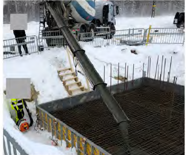
Figur 2.14. Gjutning av ett jordfundament.
