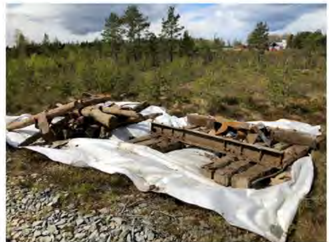
Figur 2.20. Stolp- och stagfundament som grävts upp och lagts på geotextil.
