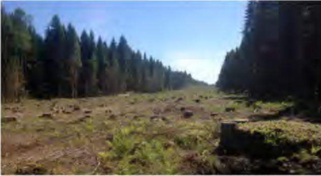
Figur 2.12. Exempel på avverkad ledningsgata inför ny ledning.
