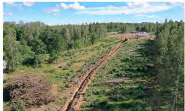
Figur 2.17. Schaktning av marklina inför ny kraftledning.
