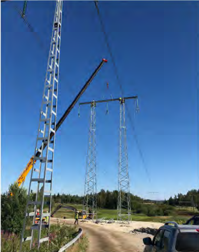
Figur 2.15. Resning av en portalstolpe.
