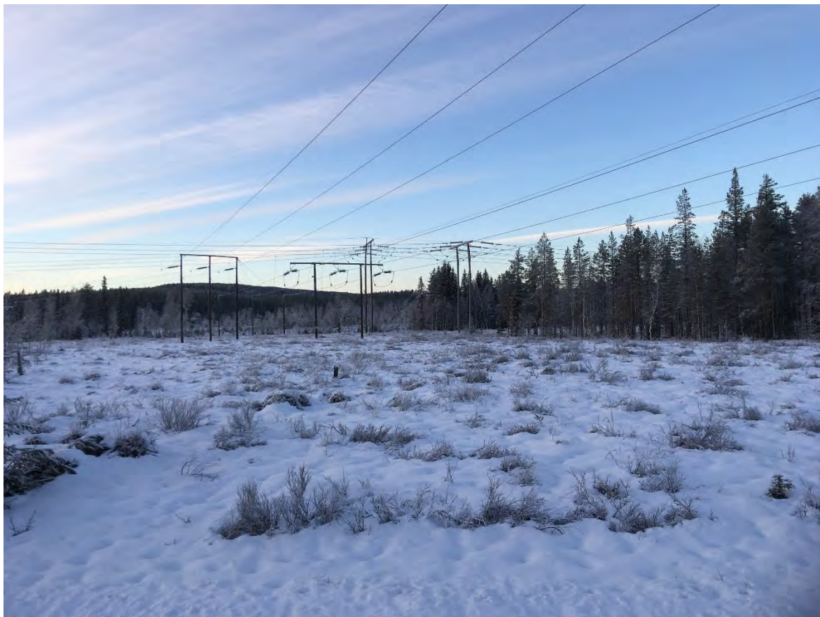
Figur 7. Korsningspunkt för E.ON:s befintliga 130 kV-ledning (406 Fd, till vänster) och Svenska kraftnäts 220 kV-ledningar (AL3 S1, AL3 S2 och AL6 S5-6, två högre stolpar till höger). Härifrån utgår också Svenska kraftnäts 220 kV-ledning (AL3 S9, mittenstolpen) mot Degerforsens kraftverk. Ledningsgatan omges av huvudsakligen barrskog och våtmarksområden. Fotot taget från riksväg 90 i västlig riktning.
