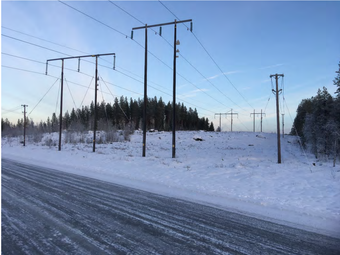
Figur 8. Riksväg 90 korsas av gemensam ledningsgata mot Degerforsens kraftverk. Från vänster: Svenska kraftnäts befintliga 220 kV-ledning (AL3 S9), E.ON:s befintliga 130 kV-ledning (406 Fd) och samt 20 kV-ledning. Ledningsgatan omges av huvudsakligen barrskog och ett avverkat område. Fotot taget från riksväg 90 i östlig riktning.
