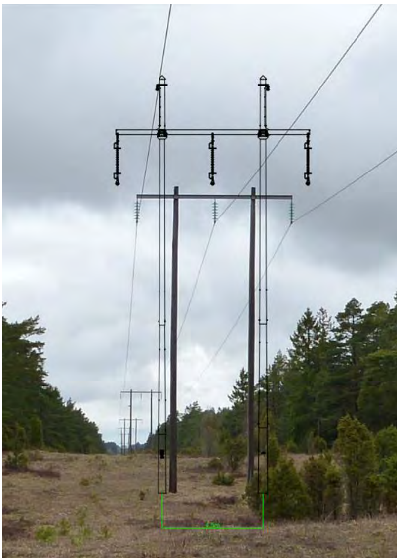
Figur 2: Fotomontage som jämför befintlig 84 kV ledning i träportalstolpar och hypotetiska portalstolpar för en 145 kV-ledning i träsäker skogsgata
