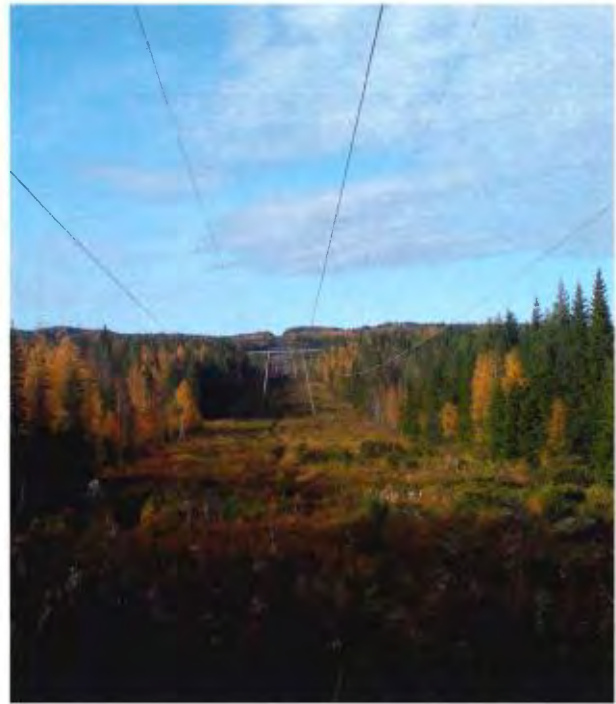
Figur 4.3 Ledningsgata i skog, bilden tagen mot väster.
