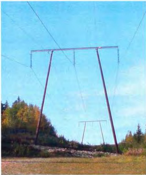
Figur 4.2 Portalstolpar av trä med stålregel, bilden tagen mot väster.
