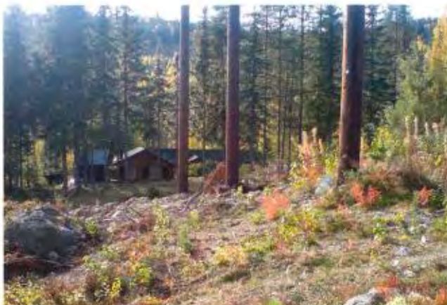
Figur 6.7. Hus nära ledningen. Bilden tagen mot söder, ledningsstolparna syns i förgrunden.
