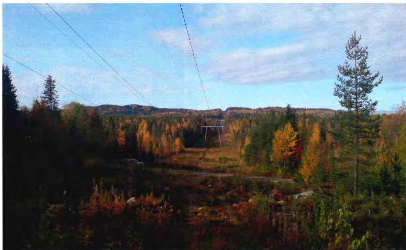
Figur 3.1 Ledningen sträcker sig genom landskapet mellan Krångede och Hammarstrand. Bilden är tagen mot väster.
