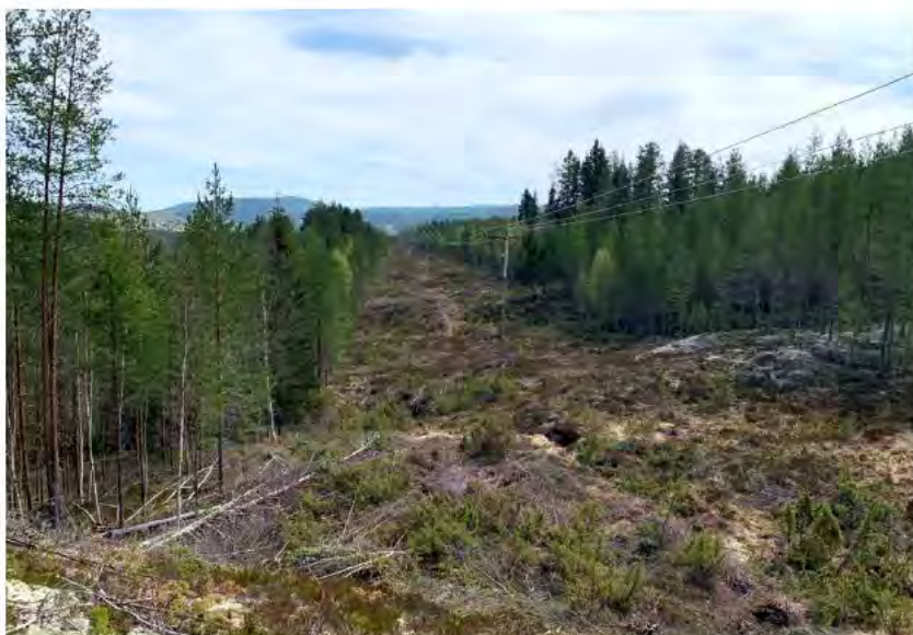
Figur 3. Enkelstolpe tillhörande befintlig 72,5 kV ledning L185.
