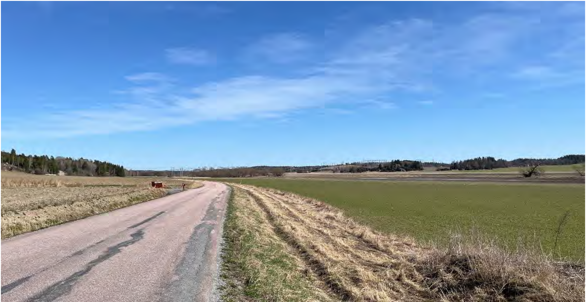
Figur 11. Fotomontage över lågbyggda portalstolpar över jordbruksmark strax öster om Fiskmansbo och väster om Högby, se 9 SV i Figur 1. Vy mot sydost. I bakgrunden syns Hamra station och åt vänster i bild de befintliga ledningarna som går till Högby. Området ligger inom ett riksintresse för kulturmiljövård.
