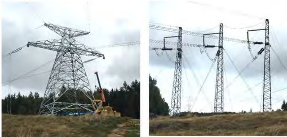
Figur 9. Exempel på vinkelstolpar. Till vänster en stubbe och till höger traditionell vinkelstolpe.
