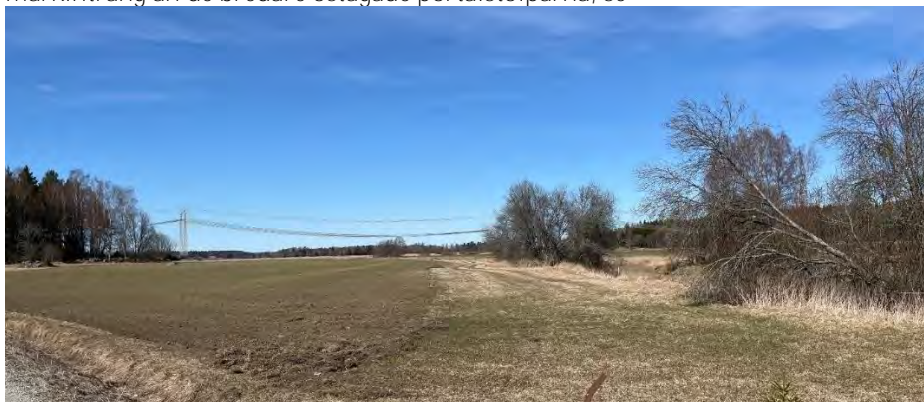
Figur 8. Ostagade portalstolpar (B-stolpar) används i jordbruksmark, eftersom de minskar ytan för odlingshinder i öppna områden, se
