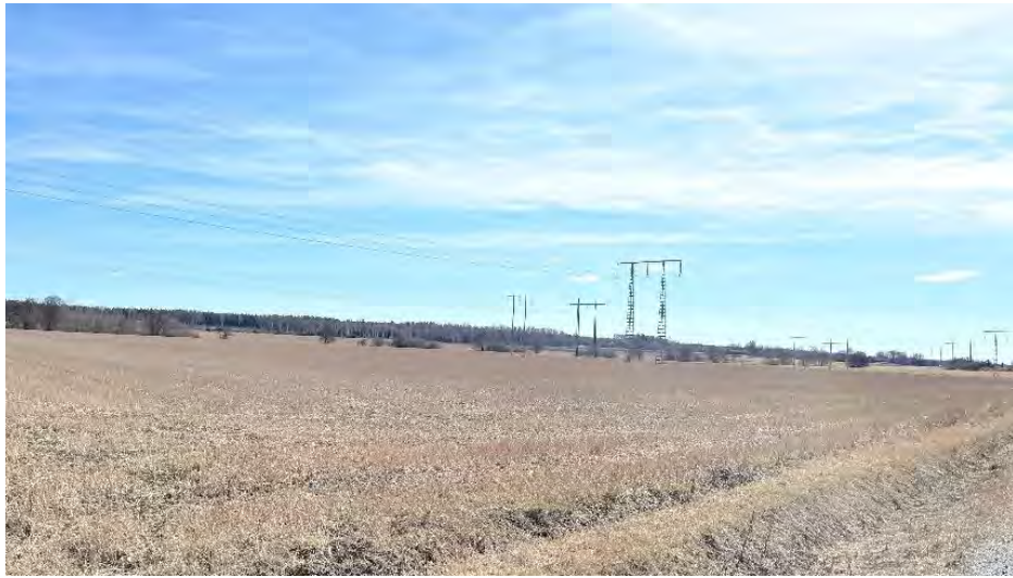
Figur 41. Utblick över det öppna jordbrukslandskapet vid Hallsta strax öster om den planerade Munga station. Foto är taget längs vägen strax sydöst om Brunnsby. Flertalet befintliga ledningar syns i bakgrunden. Ledningarna är tydligt definierade och ett betydande inslag i landskapsbilden i det flacka jordbrukslandskapet. Vy mot sydost.
