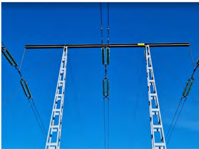
Figur 2. Stolpe med spännkedjor och utan slack för att isolera en sektion.
