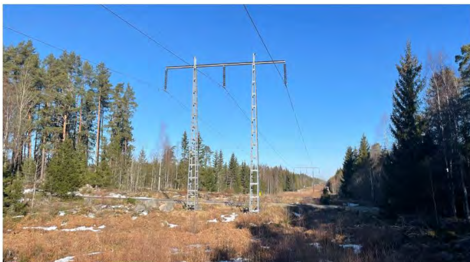
Figur 31. Befintlig 220 kV-ledning och planerad ledningsgata genom skogsmark.
