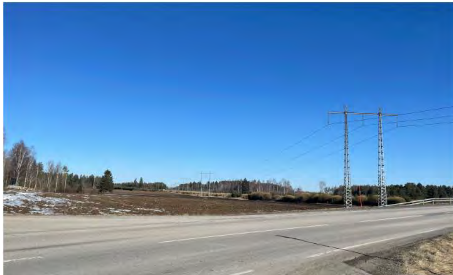
Figur 17. Befintlig och planerad ledningsgata genom växelvisa jordbruksmarker vid Torkelsbo i anslutning till E4:an.
