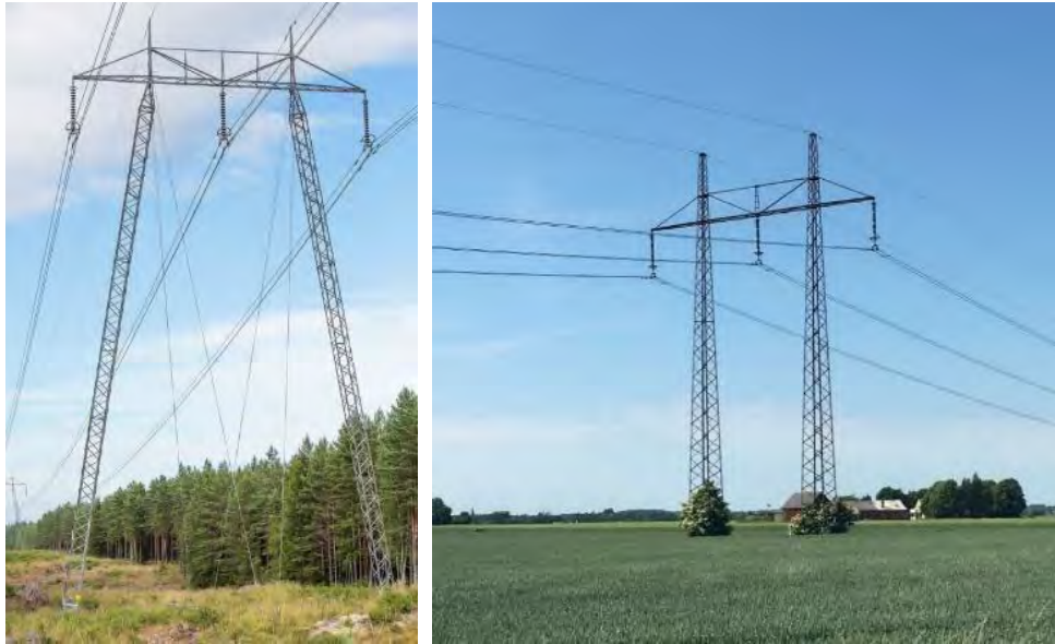
Figur 4. Exempel på portalstolpar. Stagad A-stolpe till vänster och ostagad B-stolpe till höger.
