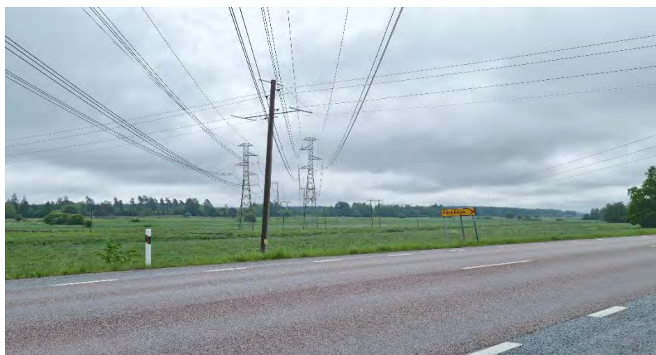
Figur 24. Fotomontage av parallellbyggda kompaktstolpar vid passage längs befintlig och planerad ledningsgata över Tämnrån och riksintresse Tierpslätten. Vy mot söder.
