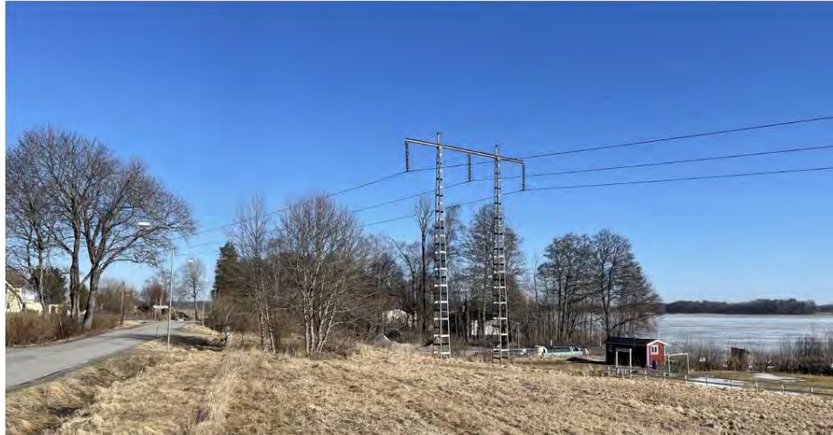
Figur 30. Befintlig 220 kV-ledning längs Långsjön i Björklinge som kommer att kunna avvecklas i samband med etablering.
