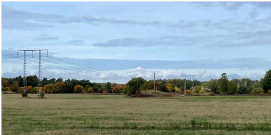
Figur 26. Befintlig och planerad ledningsgata i anslutning till Fyrisån vid Störvreta. Vy mot nordväst.
