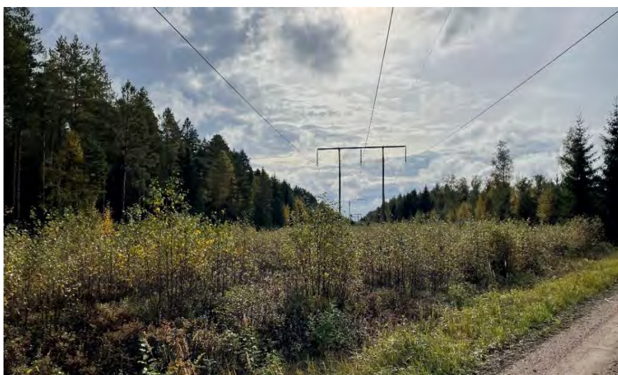
Figur 28. Befintlig och planerad ledningsgata i anslutning till östra delen av Yttröskogens naturreservat, vy mot söder.
