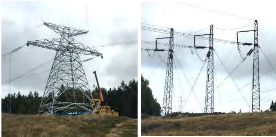
Figur 6. Exempel på vinkelstolpar. En stubbe till vänster och en traditionell vinkelstolpe till höger.
