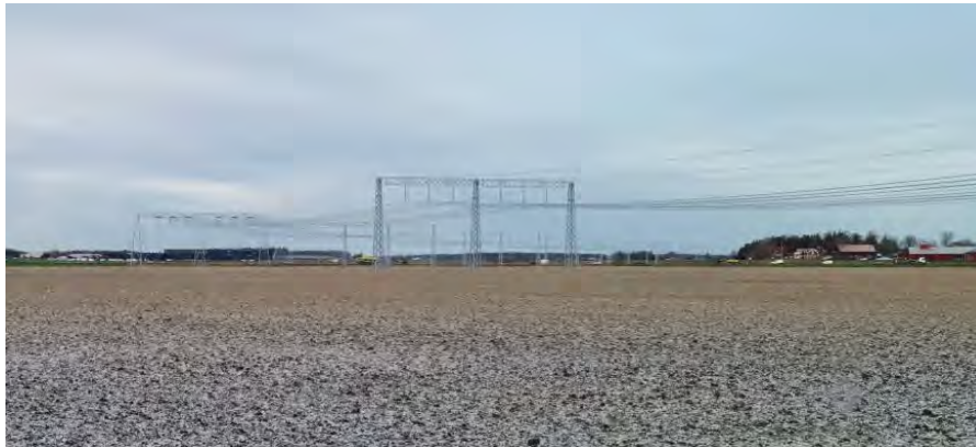
Figur 8. Fotomontage över sambyggd portalstolpe för 2x400 kV.
