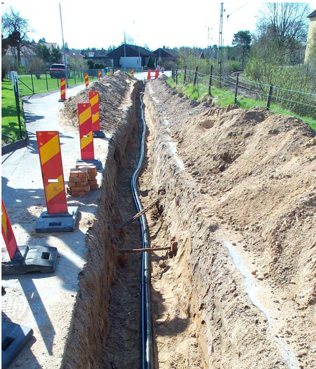
Figur 6: Exempelbild på markförläggning i ett kabelschakt med kablar utan skyddsror.
