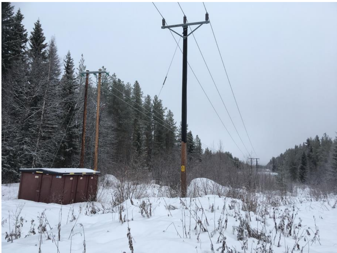
Figur 3.1: Enkelstolpe av kreosotimpregnerat trä av den typ som huvudsakligen används för den befintliga ledningen.
