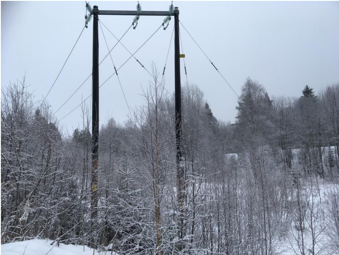
Figur 3.2: Portalstolpe av kreosotimpregnerat trä av den typ som används vid totalt fyra stycken vinklar.
