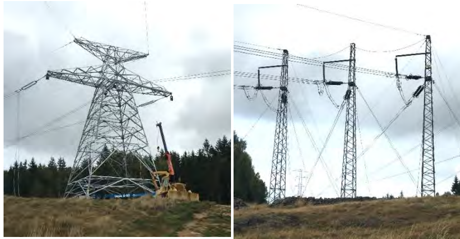
Figur 5. Exempel på vinkelstolpar. En stubbe till vänster och en traditionell vinkelstolpe till höger.
