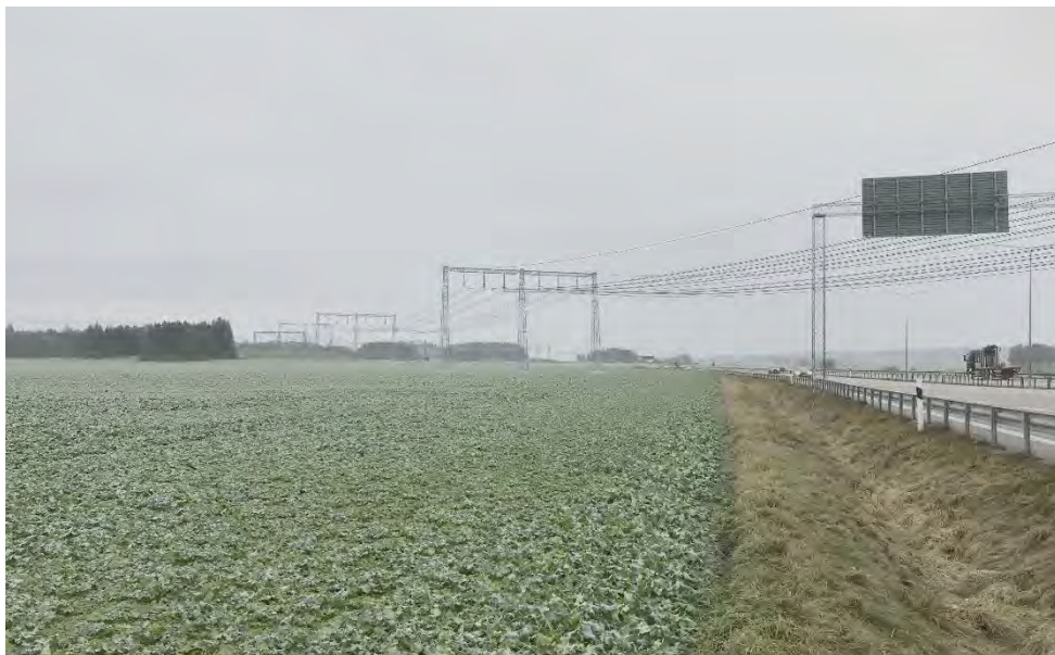
Figur 21. Fotomontage över sambyggda, lågbyggda portalstolpar över jordbruksmark norr om Danmark. Vy mot sydväst och Östra Fyrislund.
