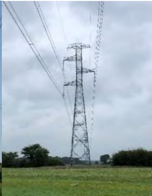
Figur 4. Exempel på julgransstolpe till vänster och kompaktstolpe till höger.
