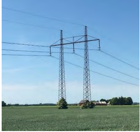
Figur 3. Exempel på portalstolpar. Stagad A-stolpe till vänster och ostagad B-stolpe till höger.
