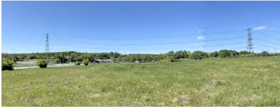
Figur 25. Fotomontage av sambyggda julgransstolpar med hindermarkering vid passage längs befintlig och planerad ledningsgata vid trafikplats Brunnby. Vy mot väster.
