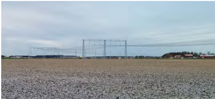
Figur 7. Fotomontage över sambyggd portalstolpe för 2x400 kV.
