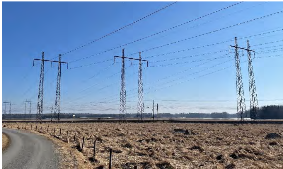
Figur 21. Foto på befintliga portalstolpar för RL8 S6 och KL42 S1 vid Bredåker som ska rivas och RL11 S1 som skall byggas om.
