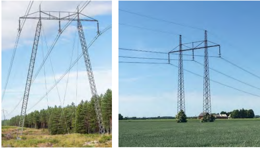
Figur 7. Exempel på portalstolpar. Stagad A-stolpe till vänster och ostagad B-stolpe till höger.
