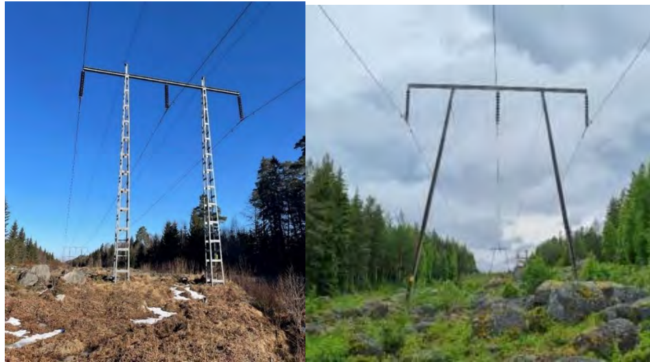
Figur 20. Foto på befintliga portalstolpar i stål och trä för KL21 S1 som ska rivas.
