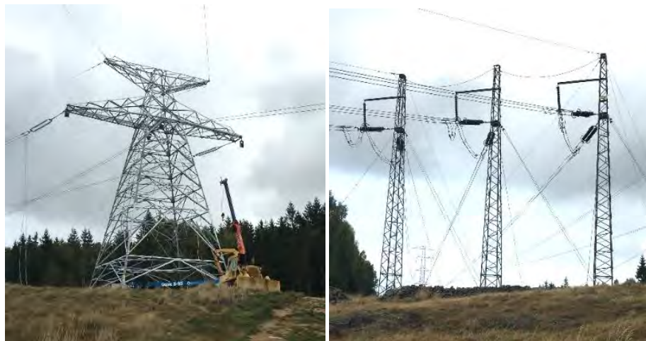
Figur 9. Exempel på vinkelstolpar. En stubbe till vänster och en traditionell vinkelstolpe till höger.
