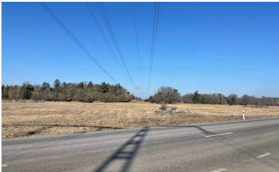
Figur 14. Korsning av befintlig 220 kV-ledning över väg 288.
