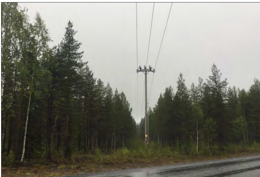
Figur 2-1. Foto på luftledningen mellan US28 vid Strömfors och station US22.
