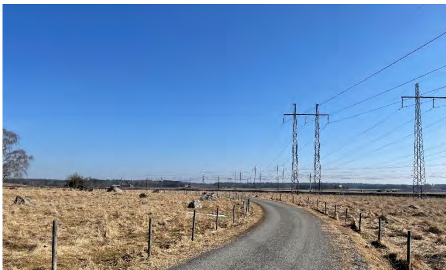
Figur 8. De tre befintliga 220 kV-ledningarna (RL8 S6, RL11 S1 och KL42 S1) i ett öppet jordbrukslandskap längs utbyggnadsförslag Bredåker-Jälla. Vy mot öster. Två av de befintliga ledningarna kommer inom Uppsalapaketet att rivas, en kommer att byggas om och en ny ledning tillkomma.
