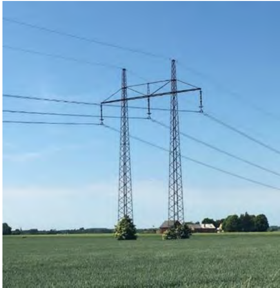
Figur 3. Exempel på en ostagad portalstolpe.
