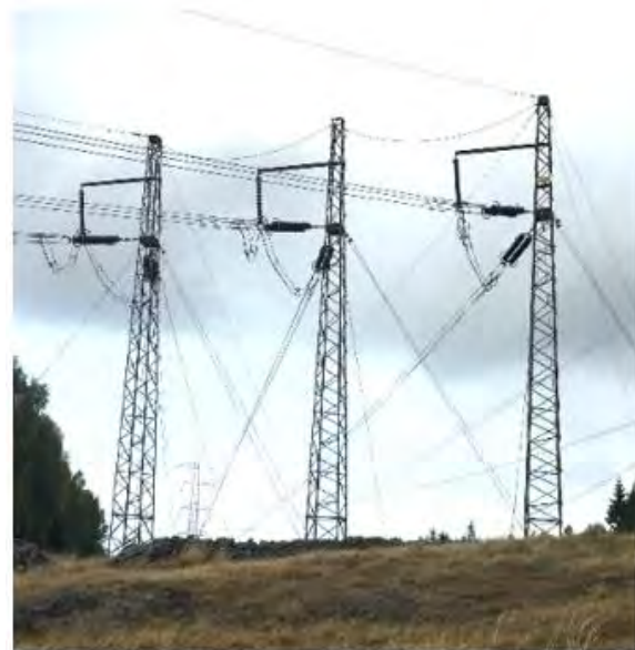
Figur 4. Exempel på vinkelstolpe.
