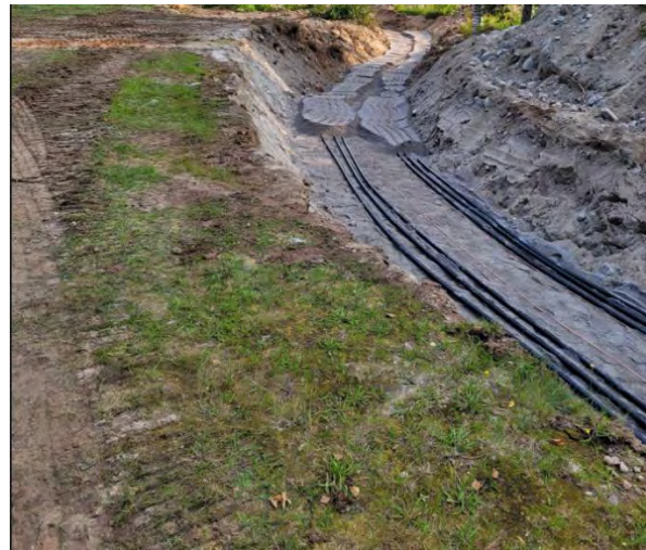
Figur 7.5. Exempel på kabelförläggning dubbla förband. Till vänster triangel, delvis i rör. Till höger plan förläggning. Foto: PiteEnergi Elnät
