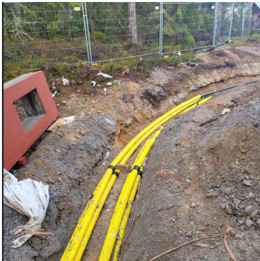
Figur 7.5. Exempel på kabelförläggning dubbla förband. Till vänster triangel, delvis i rör. Till höger plan förläggning. Foto: PiteEnergi Elnät
