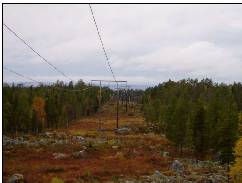
Figur 2. Foto över trädsäker 130 kV luftledning i regionnätet till vänster samt ej trädsäker 20 kV luftledning i lokalnätet till höger.
