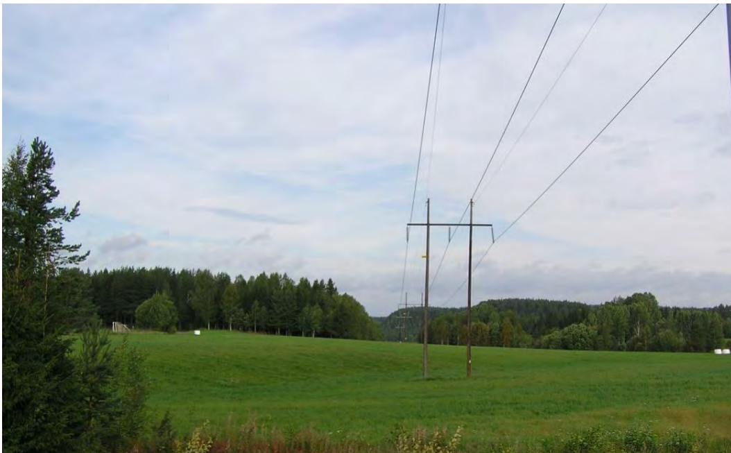
Figur 3. Foto med exempel på en ledning i portalstolpe i trä.
