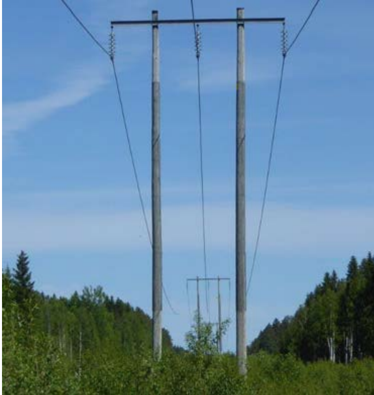
Figur 1 Bild på befintlig stolpkonstruktion
