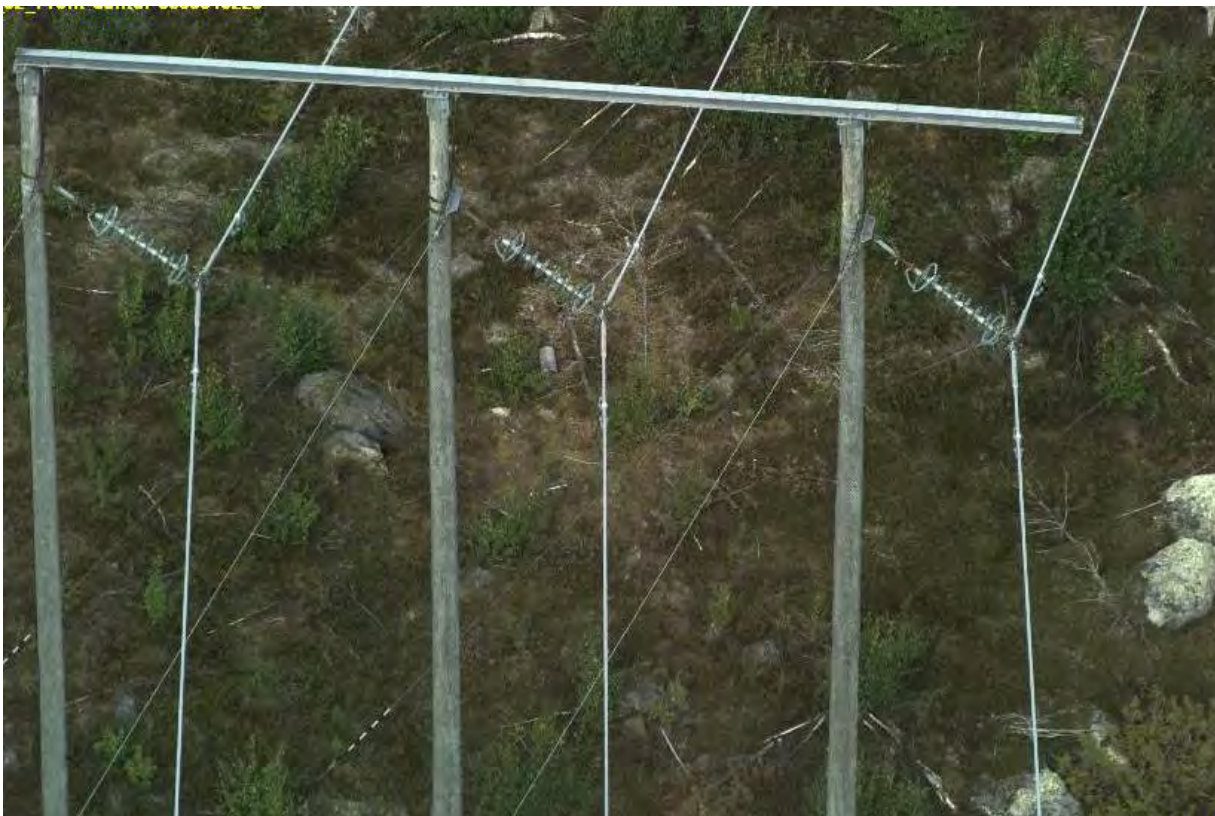
Figur 4. När stolparna stadgas upp förstärks de med en extra stolpe.
